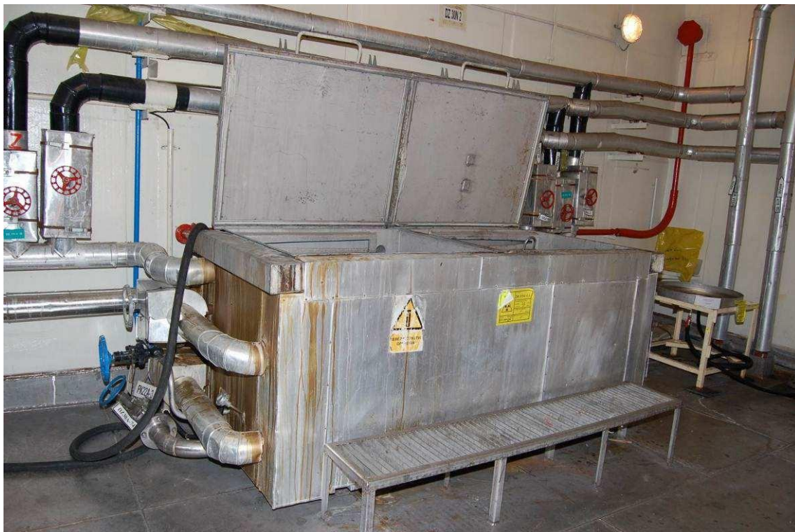
II.7 kép. A DZ30N-1 és a DZ30N-2 szennyezésmentesítő tartályok kis berendezésekhez
